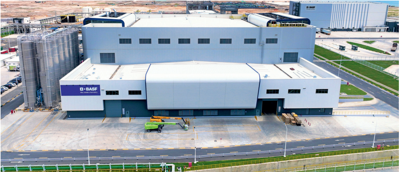
Bild 2. An seinem Verbundstandort im chinesischen Zhanjiang hat BASF eine erste Produktionsanlage in Betrieb genommen. Nach der Fertigstellung des Standorts wird dieser der drittgrößte des Konzerns sein. © BASF
